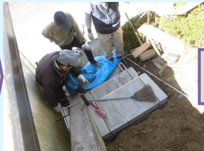
階段を設置して・・・
