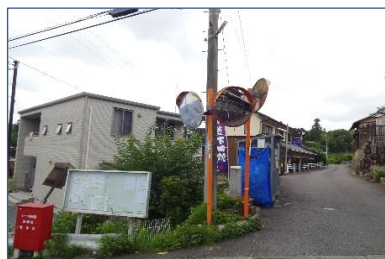
カーブミラーの新設
